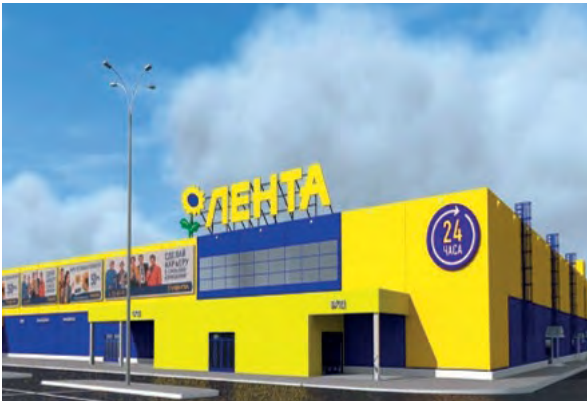
Объект: Сеть гипермаркетов "ЛЕНТА" Оборудование: Для нужд хозяйственно-питьевого водоснабжения гипермаркета "ЛЕНТА" с торговой площадью 7500 м2 поставлена насосная станция JETEX V5/08-3.
