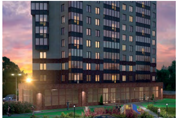
Объект: ЖК "Пифагор" Оборудование: Для противопожарной системы и нужд хозяйственно-питьевого водоснабжения 17-этажного жилого комплекса "Пифагор" произведены и установлены насосные станции JETEX VF32/02-2 и JETEX V5/9, а так же тепловой пункт LORIPS БИТП 2340-МУТ-100/125.
