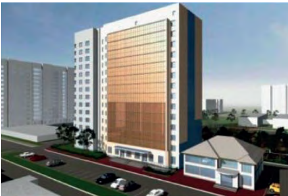
Объект: ЖК "Кристалл" Оборудование: Для нужд хозяйственно-питьевого водоснабжения 14-этажного жилого комплекса "Кристалл" произведена и установлена насосная станция JETEX V5/10-3
