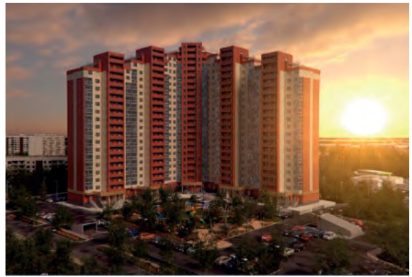
Объект: ЖК "Восход" Оборудование: Для нужд многоэтажного жилого комплекса "Восход" произведена и установлена насосная станция JETEX VF15/07-02, а так же блочный индивидуальный тепловой пункт LORIPS БИТП 3700-МНО-150/200-ЦН2-ТА2-ПН1.
